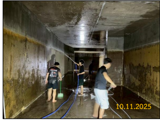
ภาพที่ 2-14 การล้างถังสำรองน้ำ
