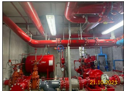
ภาพที่ 2-31 เครื่องสูบน้ำดับเพลิง
