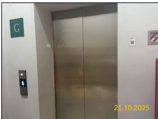
ภาพที่ 2-37 ลิฟต์ดับเพลิง
