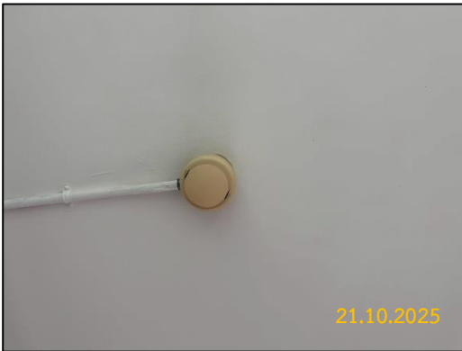
ภาพที่ 2-28 เครื่องตรวจจับความร้อน
