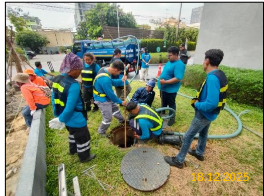
ภาพที่ 2-10 การสูบน้ำและตักกากไขมัน
