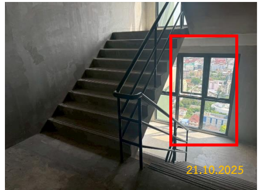
ภาพที่ 2-43 ช่องระบายอากาศ
