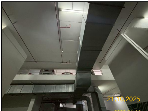
ภาพที่ 2-56 ระบบระบายอากาศบริเวณลานจอดรถ
