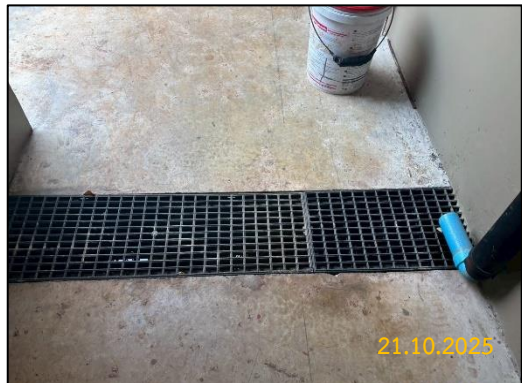
ภาพที่ 2-18 ตะแกรงดักขยะ
