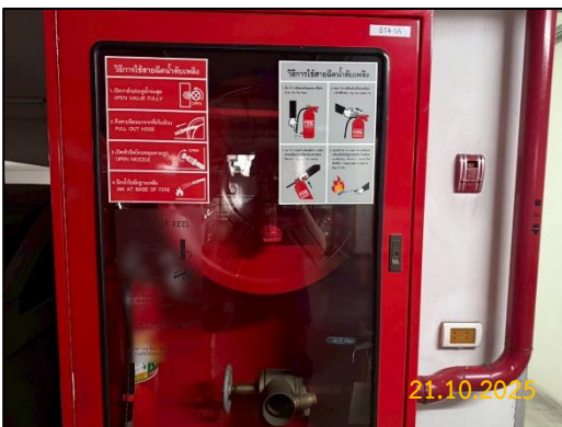
ภาพที่ 2-32 ตู้เก็บสายฉีดน้ำดับเพลิง
